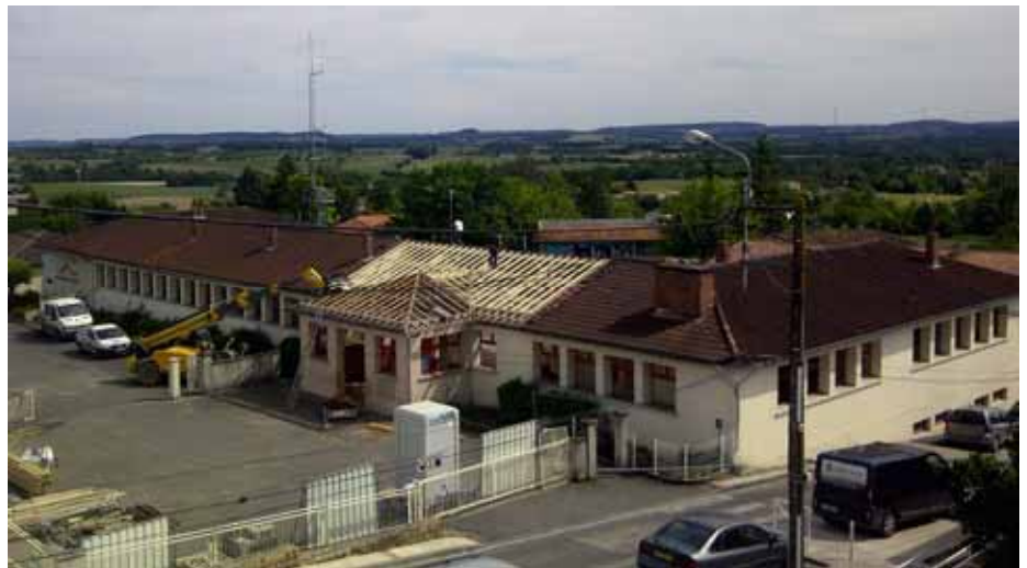
Les travaux de la maison de santé de Monflanquin viennent de débuter. Celle-ci compte parmi les trois grands projets d'investissement programmés par la communauté. (Photo R. Labrousse)
